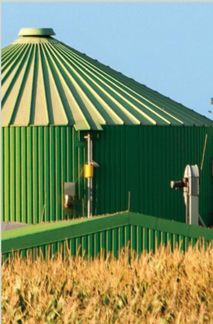
*Los depósitos de acero inoxidable garantizan una larga vida útil en los entornos corrosivos ocasionados por la materia orgánica en descomposición.*
