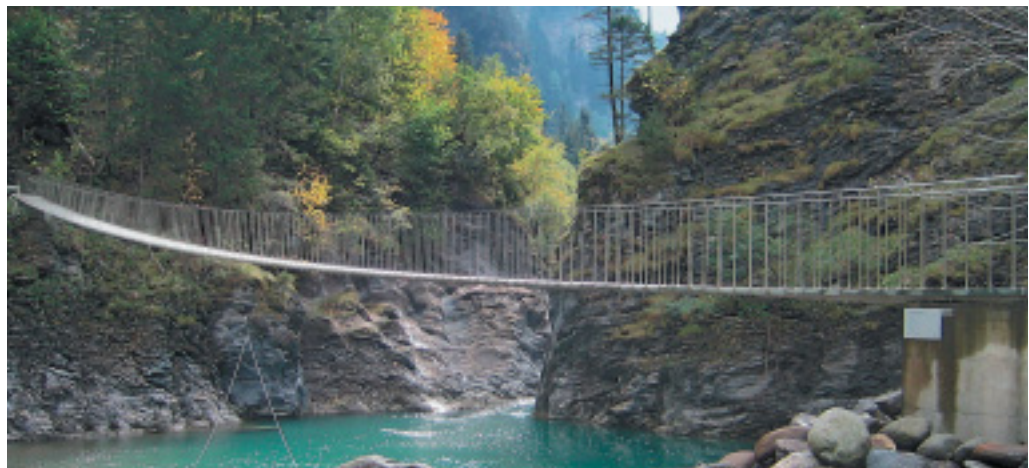
Vier dünne Edelstahlblätter mit einem Belag aus Natursteinplatten führen den Wanderweg über die 40 m breite Schlucht.
